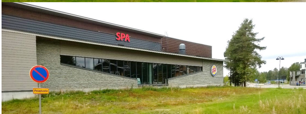
Kuva 10. Kylpylän laajennus, julkisivu pihan puolella (yllä) ja Hissitielle (alla)
