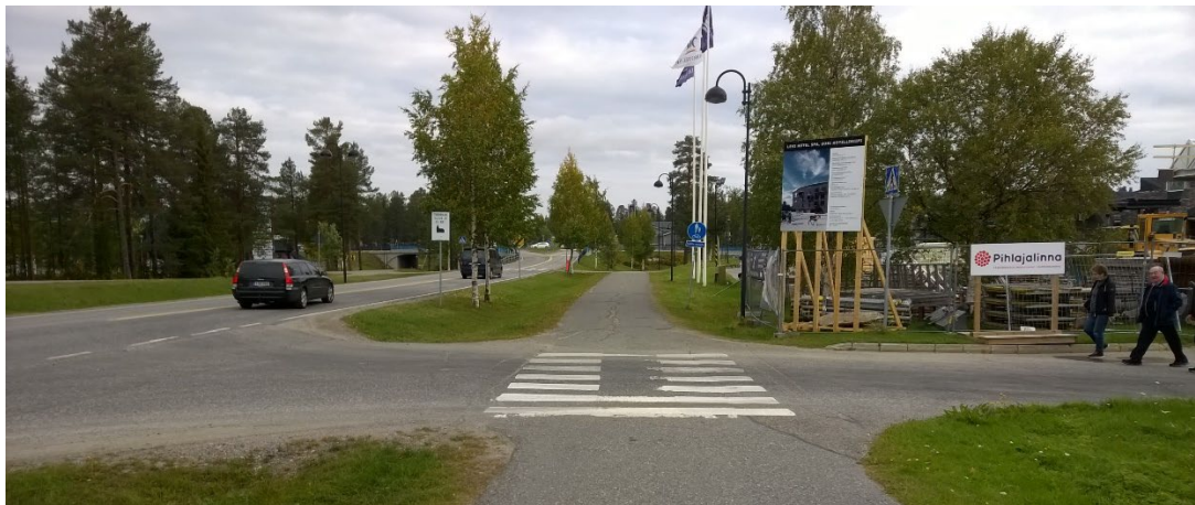
Kuva 17. Liittymä hotelliin Levintieltä (kt 79), pyörätien ylityspaikka
