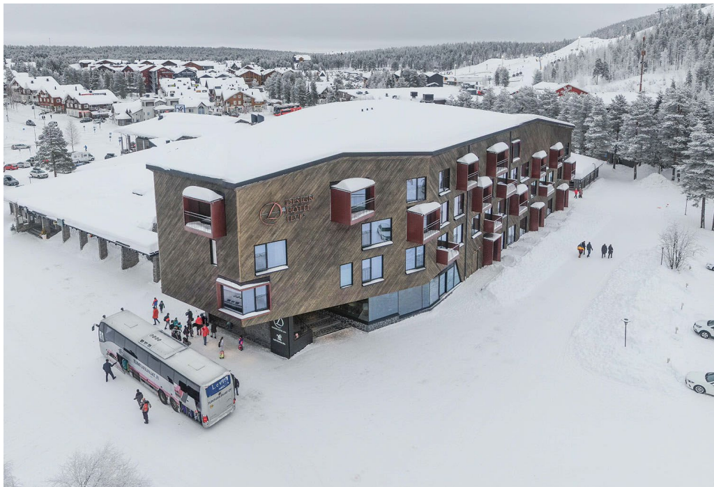
Kuva 8. Uusin rakennus, Design Hotel Levi (2019) Kuva © Pave Arkkitehdit Oy
