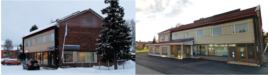
Kuva 13. Nordean pankkirakennus, kuva osayleiskaavan rakennusinventointi-raportista (vas) ja kuva nykytilanteesta (oik).
