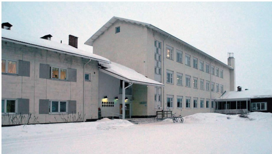
Kuva 8. Entinen emäntäkoulu (kuva osayleiskaavan rakennusinventointiraportista)
