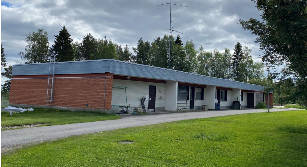
Kuva 5 Pääskylänniemen rivitalot ovat kärsineet tulvavahingoista.
