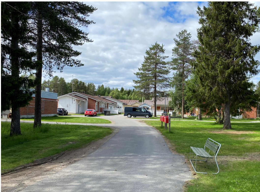
Kuva 4 Pääskylänniemen palvelutaloja kuvattuna kesällä 2021.
