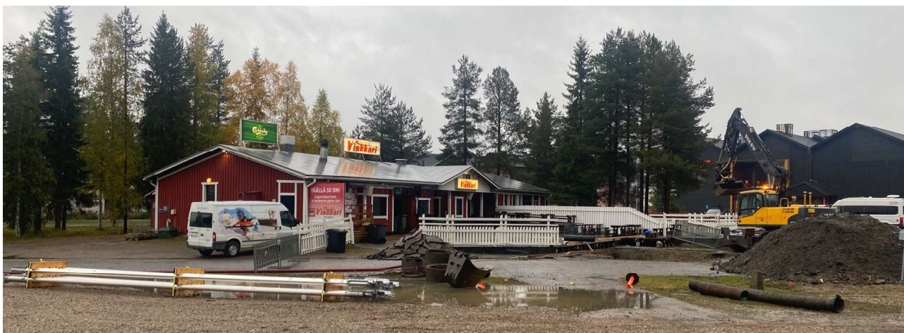
Kuva 9 Ravintolarakennus pihan puolelta. Taustalla välinevuokraamo. Kuva © Maritta Heinilä.
