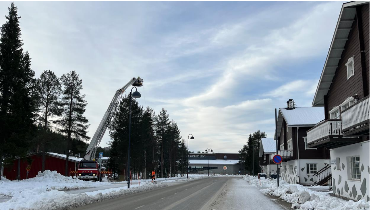
Kuva 23 Asemakaavan vaikutuksia maisemaan ja kaupunkikuvaan on tutkittu nosturin avulla. Kuvassa nosturi näkyy Hissitien vasemmalla puolella. Oikealla puolella sijaitsevien alppitalojen näkymät etelään muuttuvat nykyisestä jäsentymättömästä piha-alueesta korkeatasoiseen rakentamiseen. Näkymät Levitunturin rinteeseen ja laelle ovat nykytilanteessa pitkälti korkean kuusikon peittämiä, joten rakentamisen sijoittuminen Hissitien varteen ei aiheuta merkittävää muutosta nykytilanteeseen nähden.
