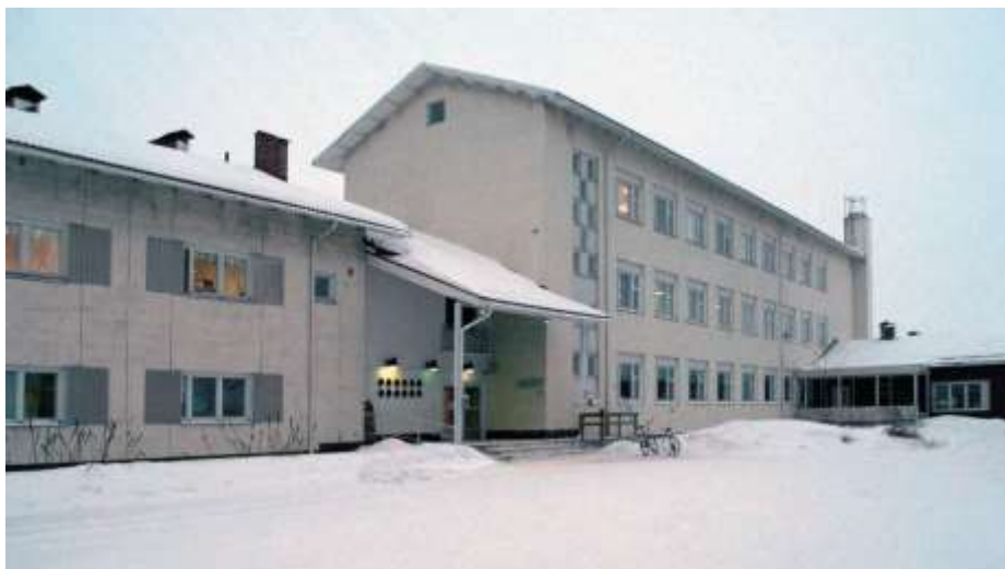
Kuva 8. Entinen emäntäkoulu (kuva osayleiskaavan rakennusinventointiraportista)
