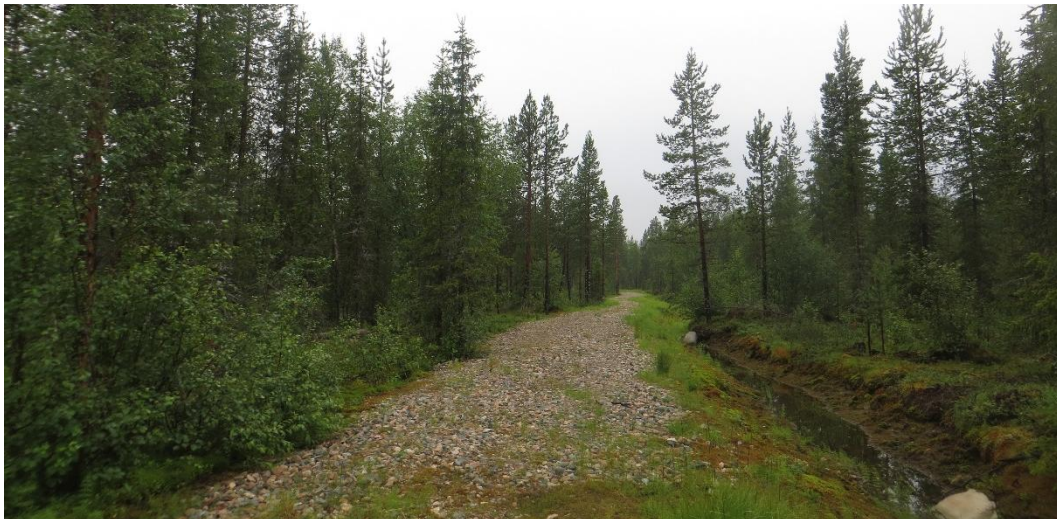
Viemärilinja rinteen alaosa.
